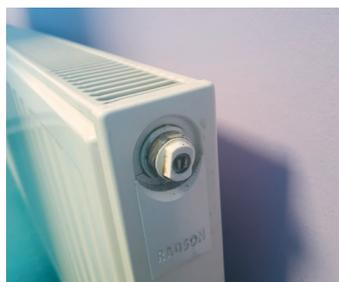
Pour pouvoir les ouvrir et laisser l'air s'échapper, munissez-vous d'une **clé à pan**. Les modèles plus récents peuvent être ouverts avec un simple **tournevis à tête plate**. Placez un récipient sous la vis de purge pour recueillir l'eau qui s'en échappera.
