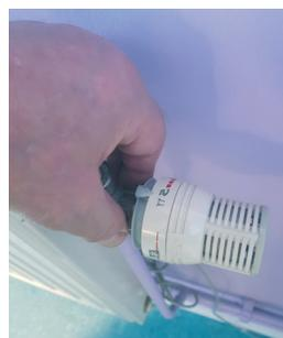
Remontez votre tête thermostatique bien droite et en position totalement ouverte (sur position 5). Revissez la bague à la main.
