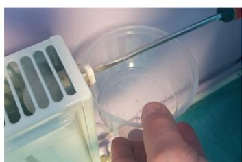
Ouvrez légèrement la vis de purge avec votre clé ou tournevis. De l'air va s'échapper (ça peut sentir très mauvais mais c'est normal). Dès que quelques gouttes d'eau commencent à sortir, laissez le purgeur ouvert encore quelques secondes puis refermez-le (rappel ; il s'agit de faire échapper un bref filet d'eau, pas de vider toute l'eau du radiateur).
